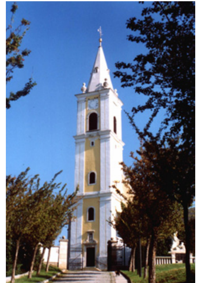
Pfarrkirche Kleinhöflein Errichtung einer Pfeifenorgel
